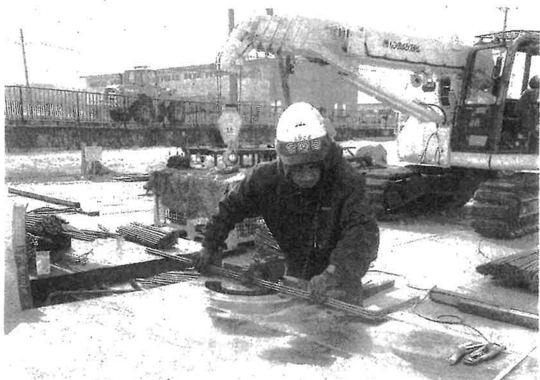
臨時の移動式工場として現場に専用機械を持ち込み、鉄筋を加工する作業員
