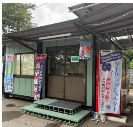
自社工場内に新設した熱中症対策室 (外観)
